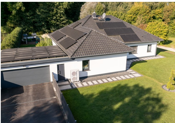
Doppelgarage und Zufahrt
