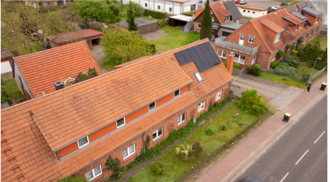
Straßenseite aus der Luft
