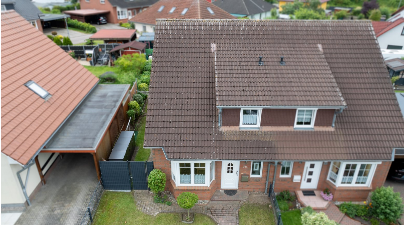
Straßenseite aus der Luft
