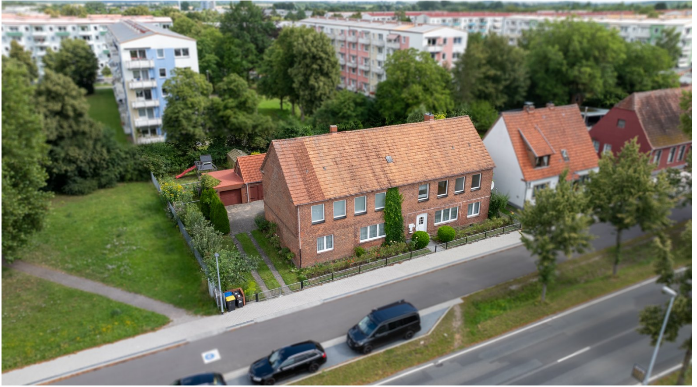
Straßenseite aus der Luft
